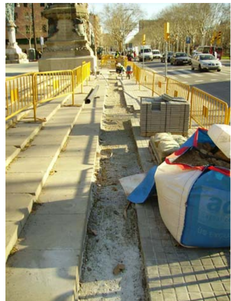
FOTO 4. Part central de la rasa, finalitzada l'excavació
