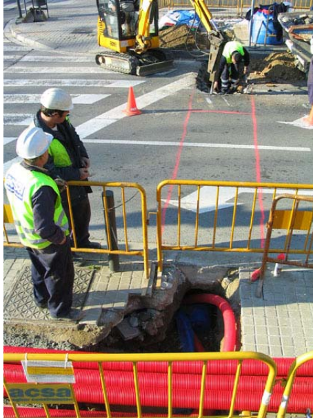
FOTO 1. Extrem sud-oest de la rasa
