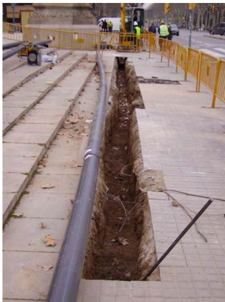
FOTO 3. Part central de la rasa, en procés d'excavació
